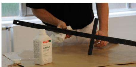
Mit der Drahtbürste wird man nur den groben Schmutz los. Reinigen Sie die Metalloberflächen deswegen mit dem ADLER Entfetter. Hartnäckiger Schmutz entfernt sich noch leichter mit einem Schleifvlies. Nach 5-10 min. können Sie mit klarem Wasser nachwaschen und alles trocknen lassen.
