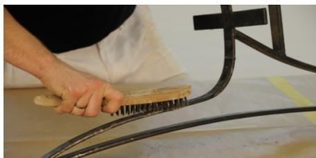
Abblätternde Lackschichten, Rost und Schmutz entfernen Sie von den Metallelementen mit einer Drahtbürste.
